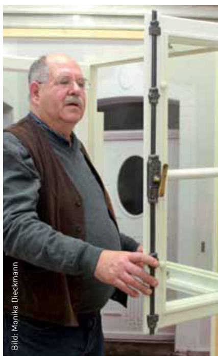
Bild: Monika Dieckmann Wolfgang Nonnenmacher zeigt seinen Kunden am Modellfenster, wie er mithilfe einer zweiten Glasscheibe den Wärmeverlust um zwei Drittel reduzieren kann.
