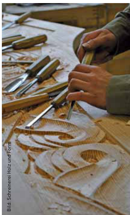
Bild: Schneiderei Holz und Form Bei der Restaurierung, wie hier bei der Rekonstruktion einer Ortgangschabracke für ein Kirchengebäude in Wetter, ist viel Handarbeit gefragt.
