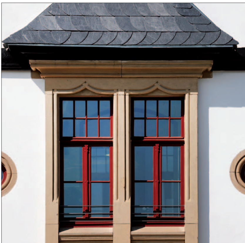
PaXretro in einem Bahnhofsgebäude, erbaut Anfang des vergangenen Jahrhunderts.
