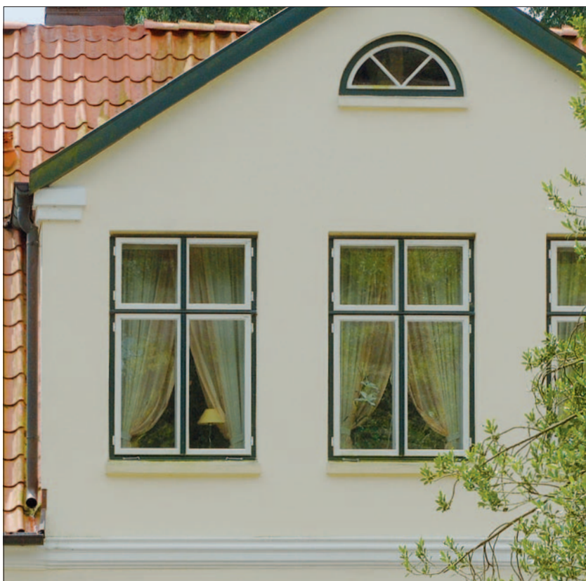
PaXsimplex im historischen Klosterhof. Rekonstruiert auf Basis eines auswärts zu öffnenden Bestandsfensters, datiert Ende des 19. Jhds.
