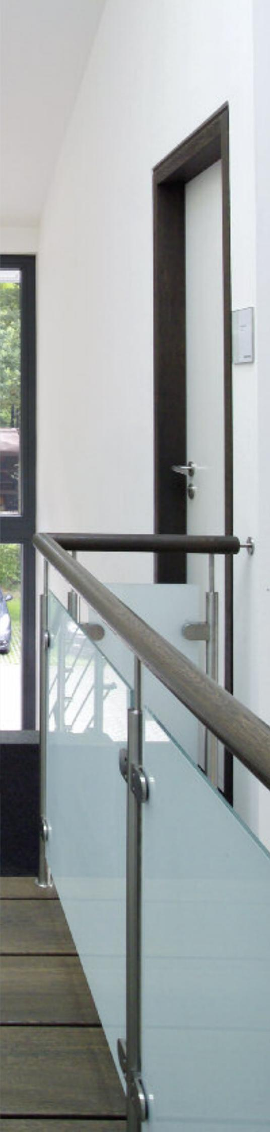
Das Treppenbau-Planungsteam entschied sich für eine klassische Podesttreppe, konstruiert als Bolzentreppe mit sandgestrahlten, 20 mm starken Granitplatten als Natursteineinleger für die Stufen. Die Farbigkeit wurde auf den Grauton der Fensterrahmen abgestimmt. Als Material für Stufen, Wangen und Handlauf präferierte man massive Eiche. Die Oberflächen des grau-silber gebeizten Holzes wurden in Ausführung „gebürstet“ veredelt.
